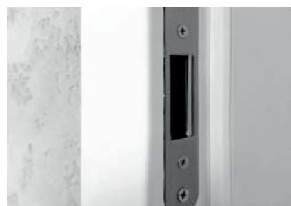
zaczep zamka magnetycznego w ościeżnicy
